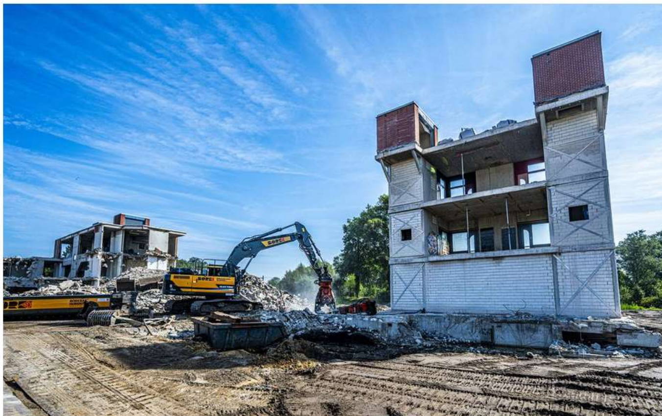
Bork en Hegeman slopen het oude RVO-pand aan de Mandemaat. Voor het nieuwe gebouw worden materialen uit het oude pand gebruikt. Rechts de afgehakte vleermuizentoren. Foto: Marcel Jurian de Jong
